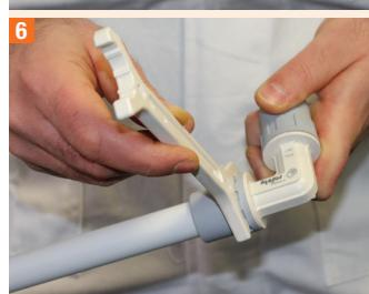
Avvitare la calotta fino alla dentellatura di sicurezza antisvitamento (utilizzare l'apposita chiave fissa serie 50600).
